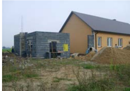
Budowa nowej remizy – 2014 r.
