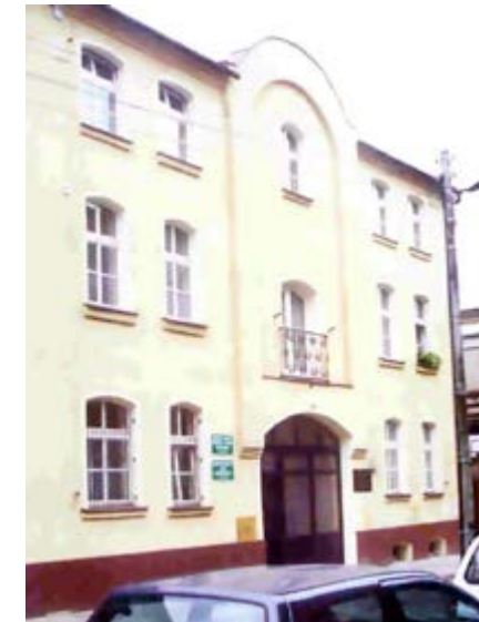
Siedziba Miejsko-Gminnego Ośrodka Pomocy Społecznej w Kępnie, ul. Ks. Wawrzyniaka 10. Zdjęcie z 1998 r.
