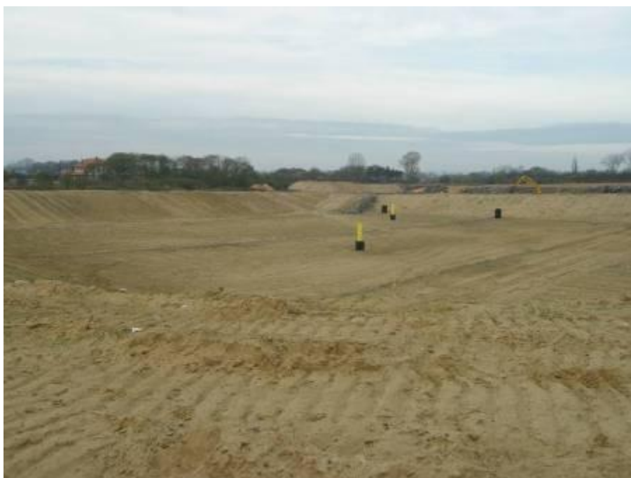
Fot. 2.5.-2. Budowa kwatery składowiska w Mianowicach
